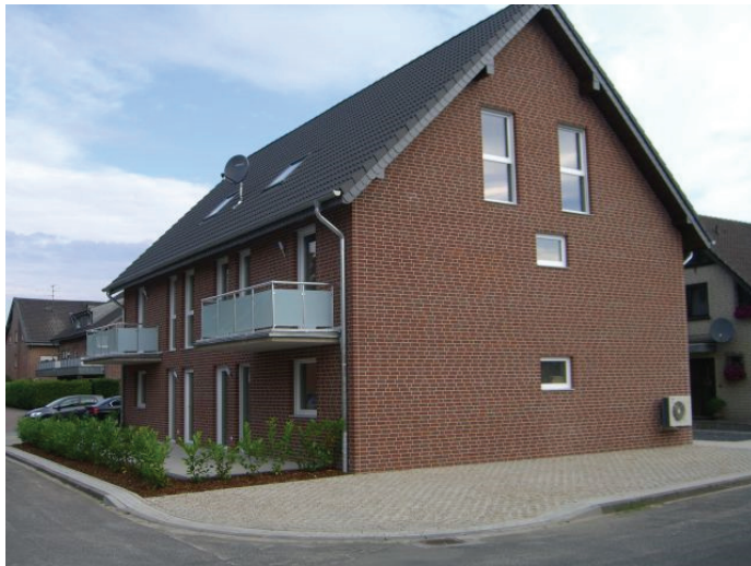
Gesamtobjekt Ostseite mit Parkfläche 2
