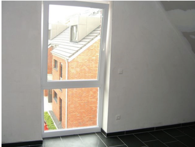
Kinderzimmer Fenster nach Westen
