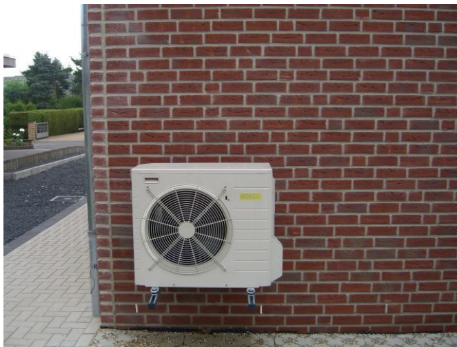
Wärmepumpe Ausseneinheit
